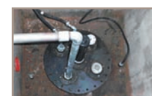
Pozzetto cisterna Tank shaft
